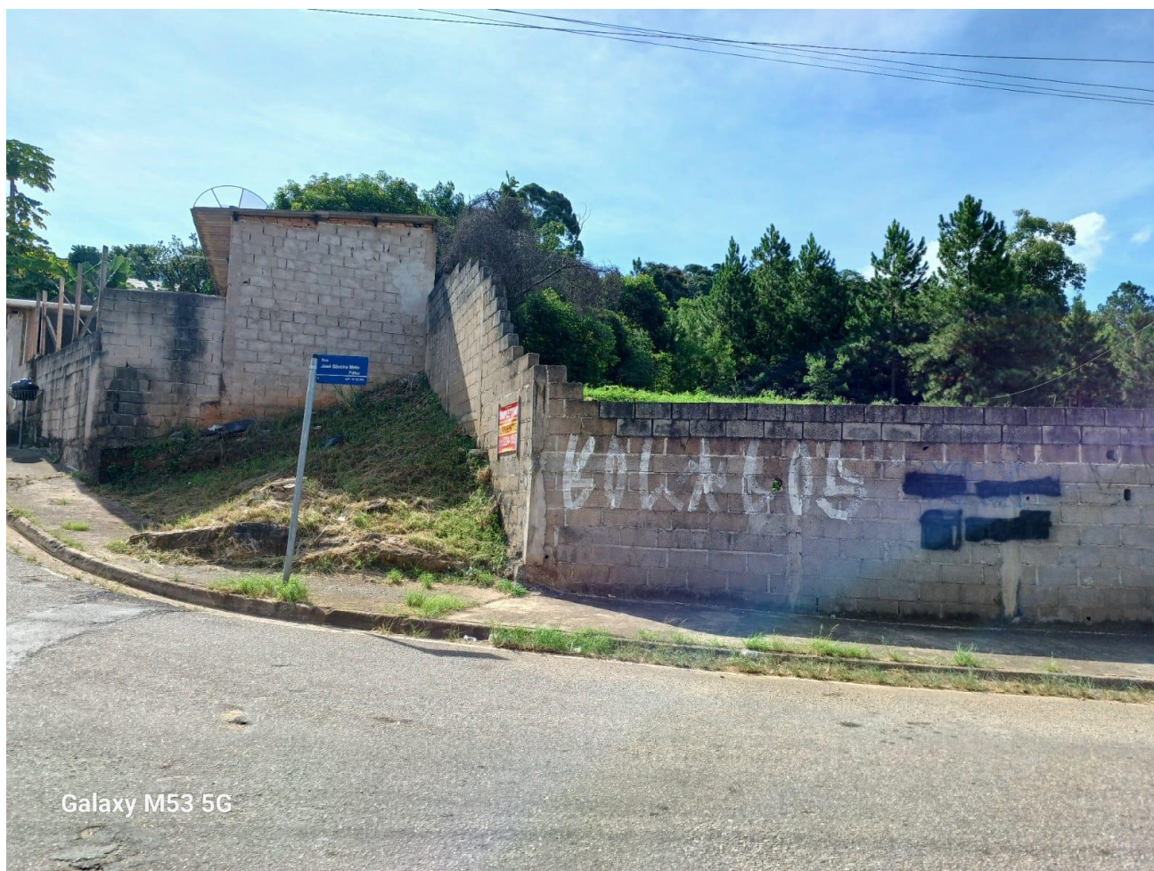
Foto 03 – Vista, esq. Rua José Silveira Mello Filho com Rua Marília
