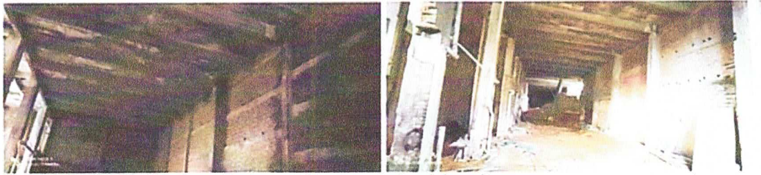
Fotos 18 e 19: destinadas a ilustrar o sistema estrutural descrito.
