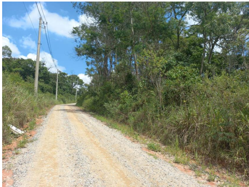
Foto 03 - VISTA DO LOGRADOURO
