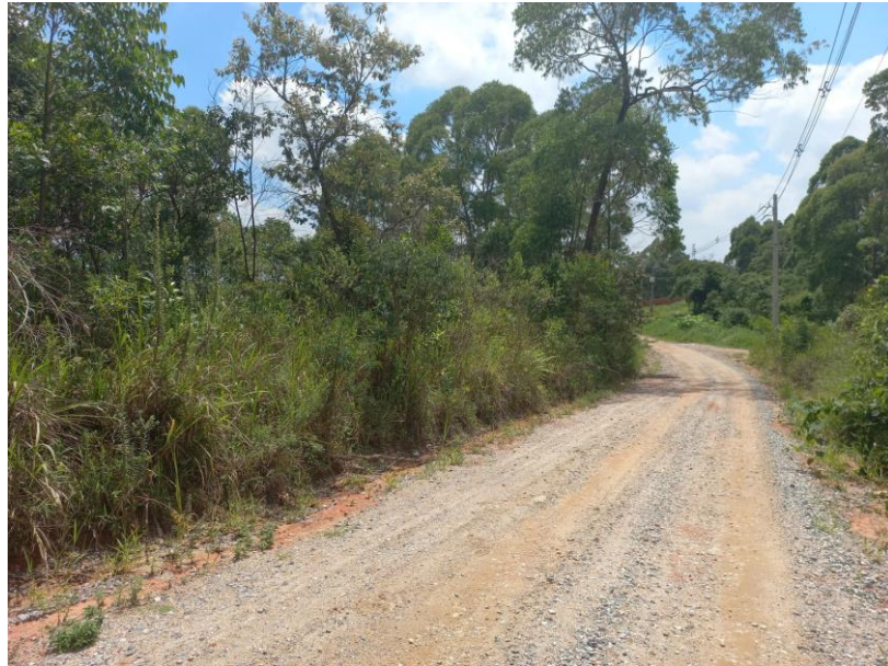
Foto 04 - VISTA DO LOGRADOURO 02
